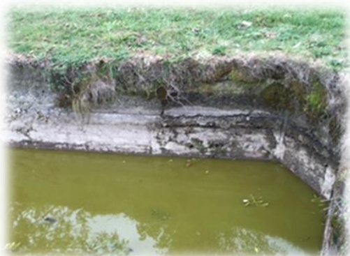
Obrázek 8: Požární nádrž Jiřetice
